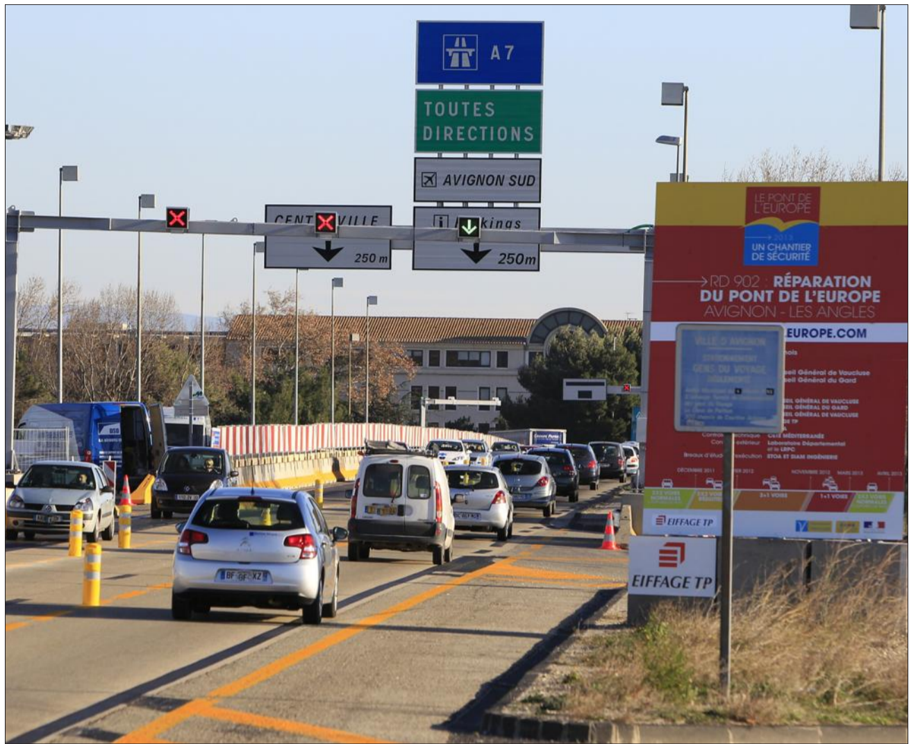
Le Vaucluse consacre chaque année entre 2,5 et 4 millions d'euros à la réparation et à l'entretien de ses ponts. Archives photo Le DL/Patrick ROUX
